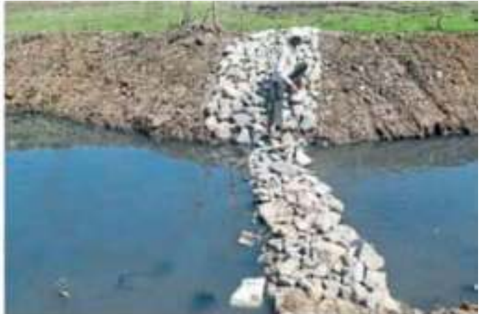
साधा दगडी बांध घालून दर काही काळानंतर त्यात अडकलेला प्लास्टिक व अन्य बाबी काढून टाकणे हे कामही सांडपाणी प्रक्रियेमध्ये महत्वाचे ठरते
